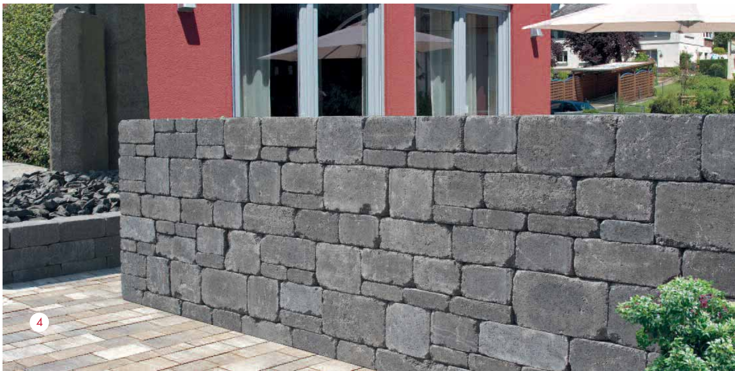
Aufbaubeispiel aus 3 Lagen im Eckverband gebaut, regelmäßiger Schichtaufbau
