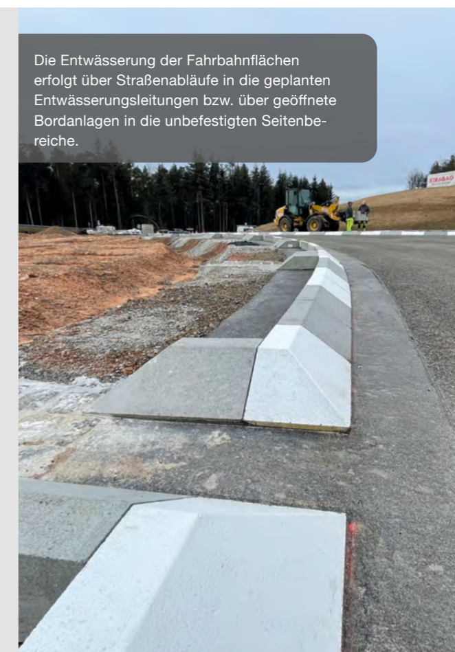
Kreisverkehren mit besonders hohem Verkehrsaufkommen: In Kaiserslautern-Einsiedlerhof wurden mit Hilfe so genannter Bypässe abgetrennte Spuren ausgebildet, mit deren Hilfe der Verkehr besonders gezielt und schnell um den dann so genannten Turbo-Kreisel geleitet wird.
