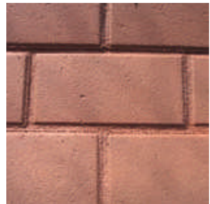
Sauber freigelegte Fase der Betonpflastersteine.
