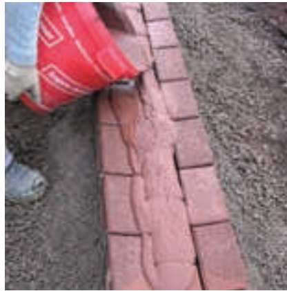
Einbringen der farblich abgestimmten Sopro TrassNatursteinFuge.
