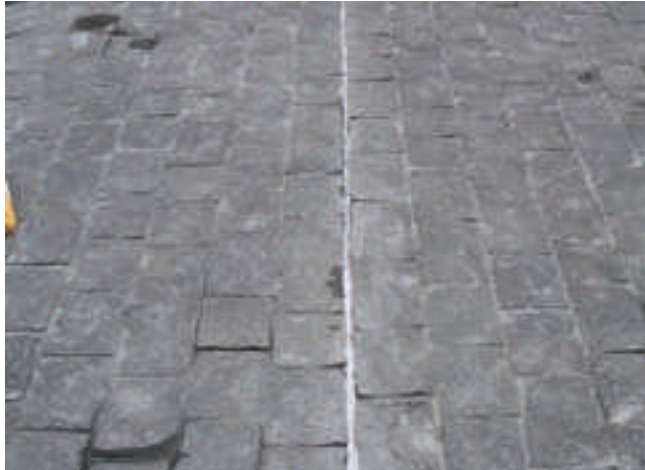
Verfüllen des Einschnitts mit einem elastischen Dichtstoff.
