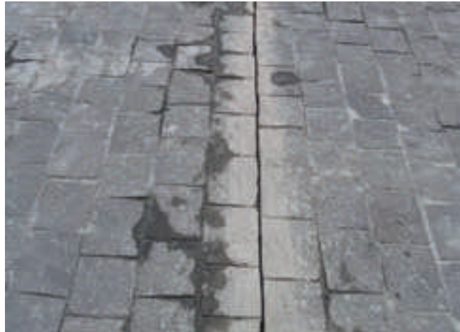
Einschneiden des Belags nach dem Ausfugen.
