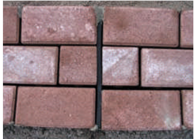
Eingebaute Gummischeibe bei Betonpflasterbelägen als Bewegungsfuge.
