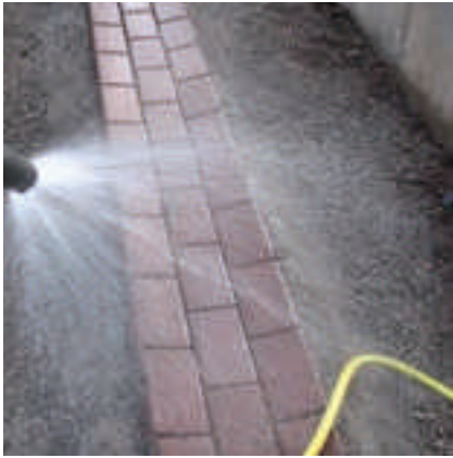
Betonpflastersteinrinne gut vorgenässt.
