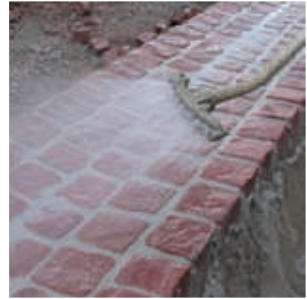
Reinigen der Fläche nach ansteifen des Fugenmörtels mit Sprühlanze.
