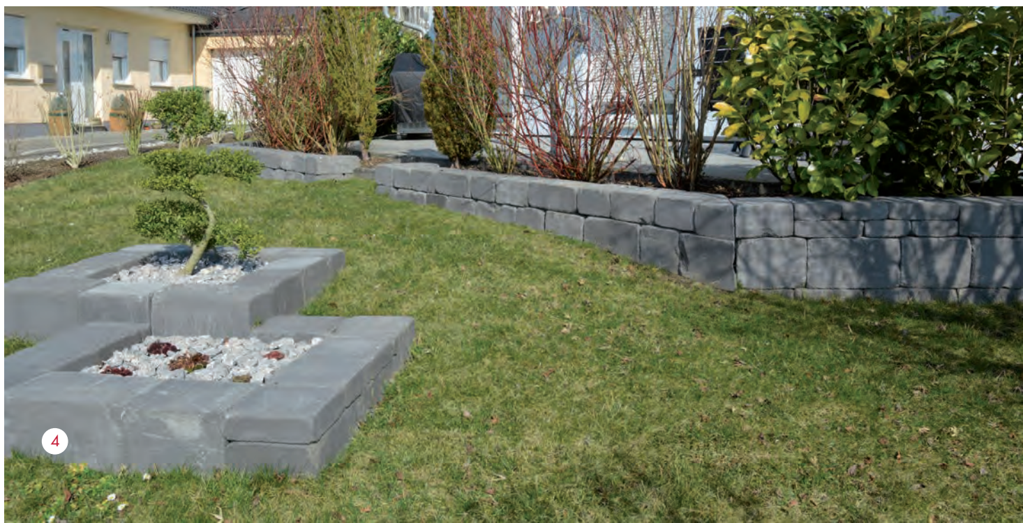
Aufbaubeispiel aus 3 Lagen im Eckverband gebaut, regelmäßiger Schichtaufbau
